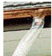
Anwendung: Schlauch aus PE-Folie wird an der Dachrinne angebracht und verhindert das Verschmutzen der Fassade durch Regenwasser o.ä.
