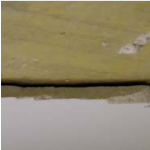
3 Die Randbereiche sind am Tag der Ablösung noch mit dem Beton verbunden. Ein Tag später ist der Randbereich ebenfalls ablösend.
