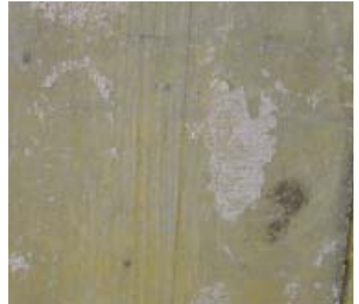
2 Hier hat sich der Deckenputz komplett abgelöst. Kleine weiße Reste zeigen an, dass der Deckenputz nur »pfötchenhaft« mit der Decke verbunden war.
