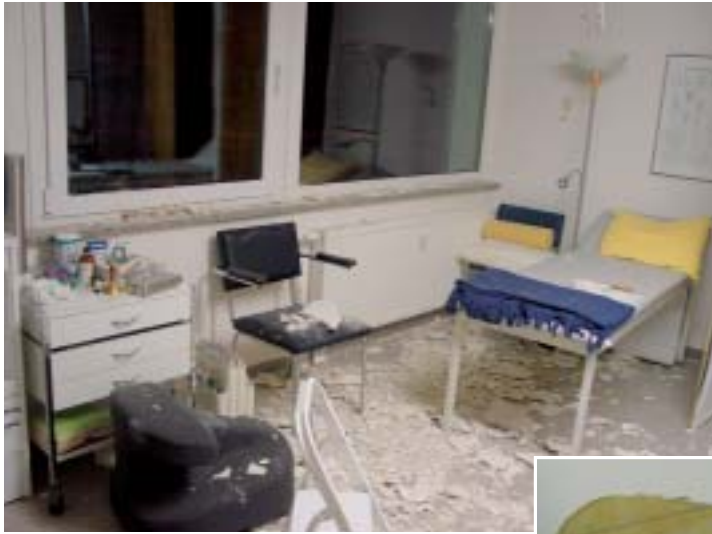
1 Eine Deckenputzablösung in einer Arztpraxis und (kleines Foto; ein Jahr nach Putzauftrag) in einer Behörde. Ursache war in beiden Fällen zu hohe Restfeuchte im Beton.
